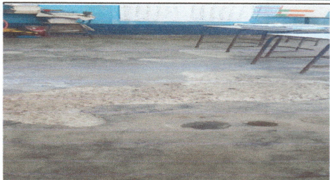
Foto 2: Sustitucion de piso de torta por piso ceramico nogal,
