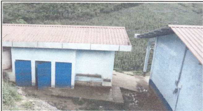
Foto1: Mantenimiento de las puertas, lijado y aplicación de pintura
