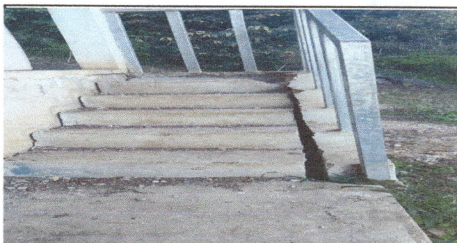
Foto 6: Sustitucion de gradas del Cdentro Educativo
