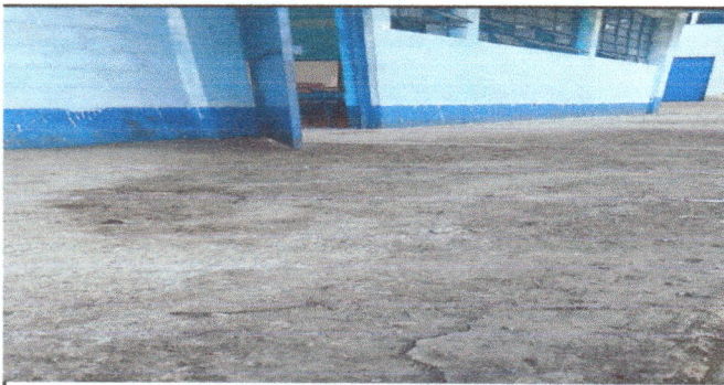
Foto 5: Aplicación de pintura interior y exterior
